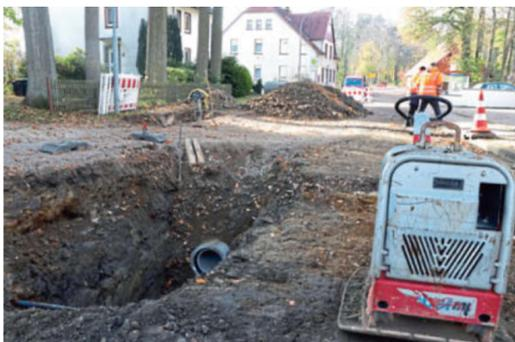
An der Baustelle Neuenkirchener Straße ist in dem großen Loch das Ende eines neu verlegten Regenwasser-Kanalrohres zu sehen.
