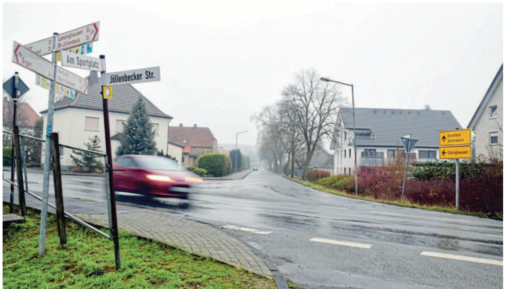
Hier an der Jöllenbecker Straße, Ecke Sundernstraße/Am Sportplatz, könnte ein Kreisel entstehen.
