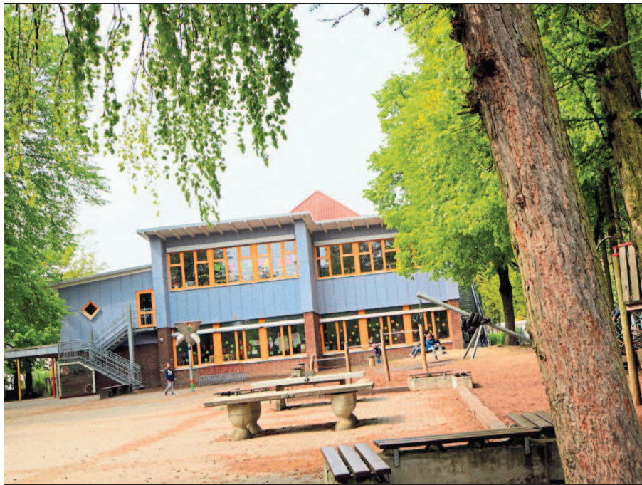
Die Grundschule Enger-Mitte an der Poststraße ist baufällig. Bei einer Sanierung könnte der Unterricht vorübergehend in Containern abge-
